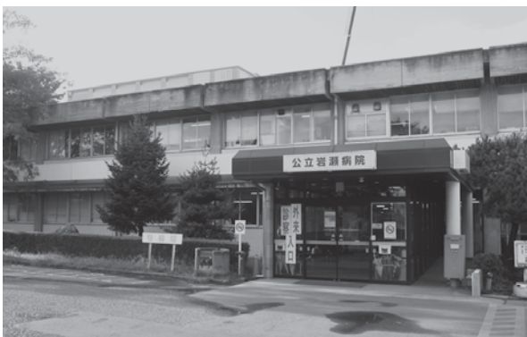
写真1 公立岩瀬 旧正面玄関
