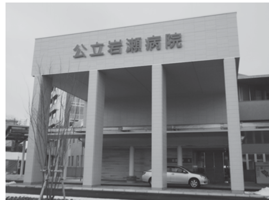
写真3 公立岩瀬病院 新玄関
